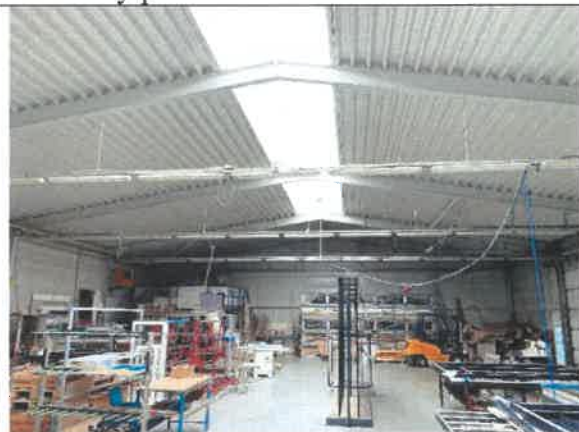
Výrobní hala - interiér
